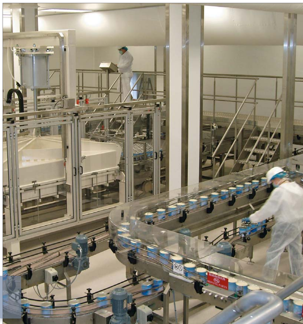
Jorgensens gasenheder med div. conveyors.
